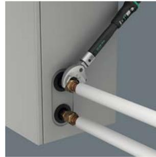
Con l'assortimento 9530 è possibile il corretto serraggio degli avvitamenti per impianti di refrigerazione e condizionamento dell'aria, nonché di pompe di calore.
